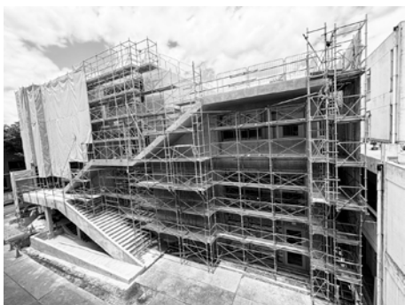
建設中の新講義棟
