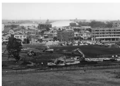
工学系総合研究棟2（電気電子工学コースが入っている建物）から見た造成風景。奥に見えるのが千葉公園新体育館等（2024.6）
